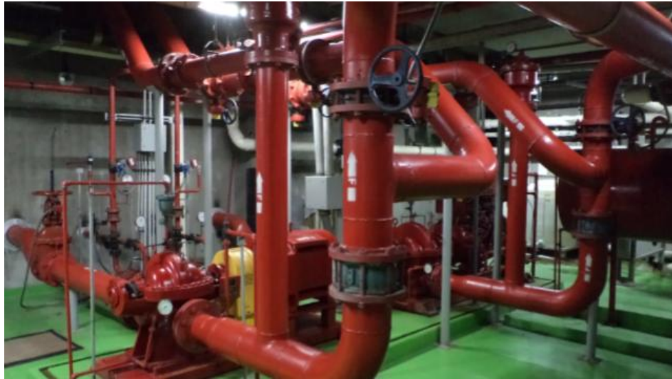
ภาพแสดง : เครื่องสูบน้ำดับเพลิง (Fire Pump) และท่อเย็นของโครงการ
